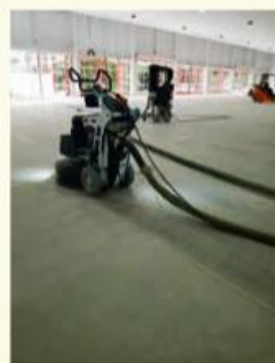
施工中の様子
